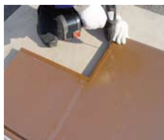
Крепление планки кассетной
