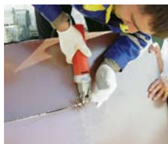
Резка фасадной кассеты просечными электроножницами
