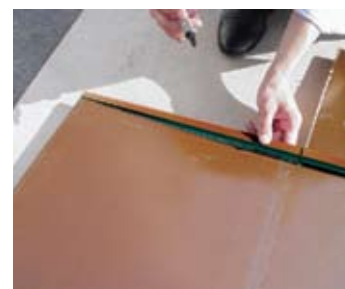
Разметка планки кассетной
